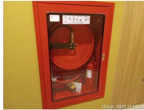
ตู้สายฉีดน้ำดับเพลิงพร้อมอุปกรณ์
