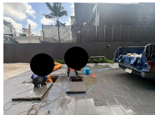
รูปที่ 2.2-16 สับกำจัดกากตะกอนและไขมัน
